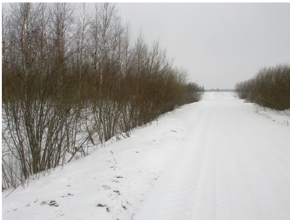
Attēls (pk 2+40) – nepieciešams apzāģēt krūmus, iztīrīt aizaugušos ceļa sāngrāvjus un izveidot jaunus, lai uzlabotu lietuss ūdens atvadi
