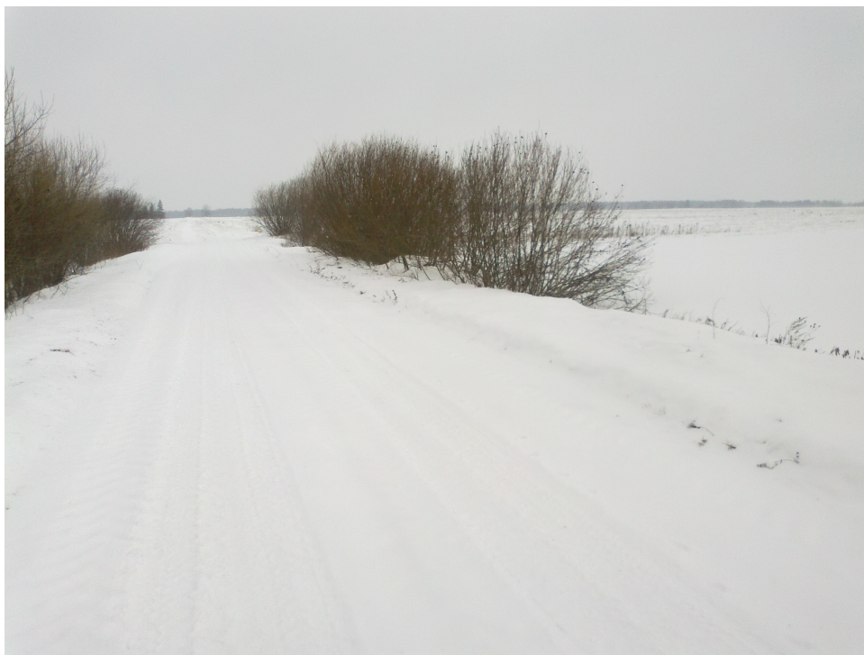
Attēls (pk 2+20) – lietuss ūdens novades nodrošināšanai, kā arī segas kūkumošanas novēršanai nepieciešams likvidēt esošo nomaļes apaugumu
