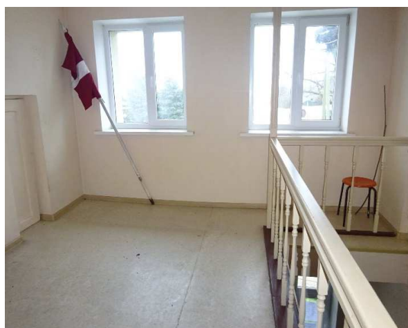
2.stāva kāpņu telpa
