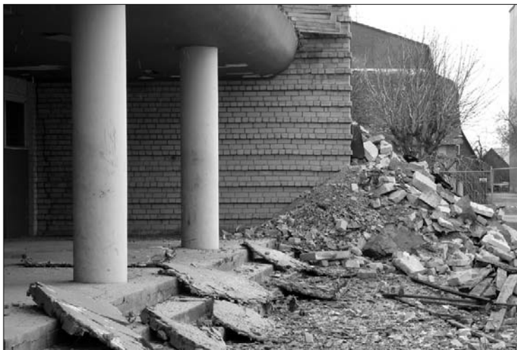
Notiek vecā kultūras centra ieejas konstrukciju demontāža
