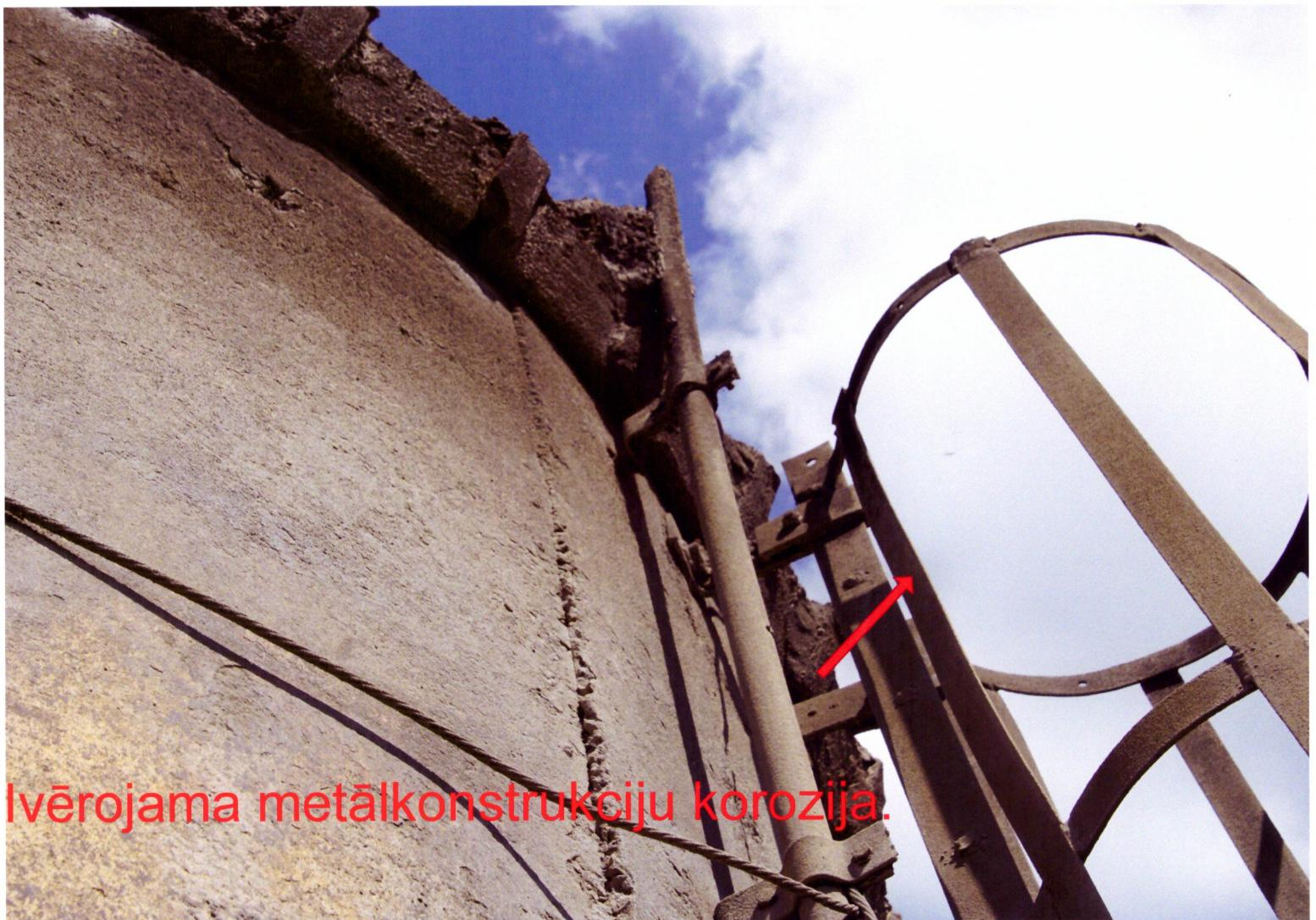
Ivērojama metālkonstrukciju korozija.
