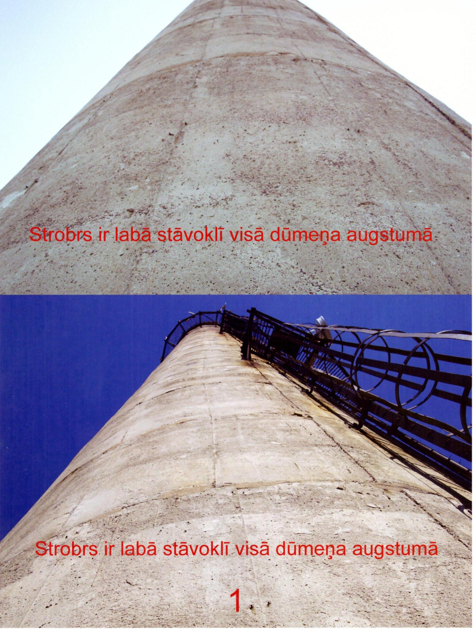
Strobrs ir labā stāvoklī visā dūmeņa augstumā
